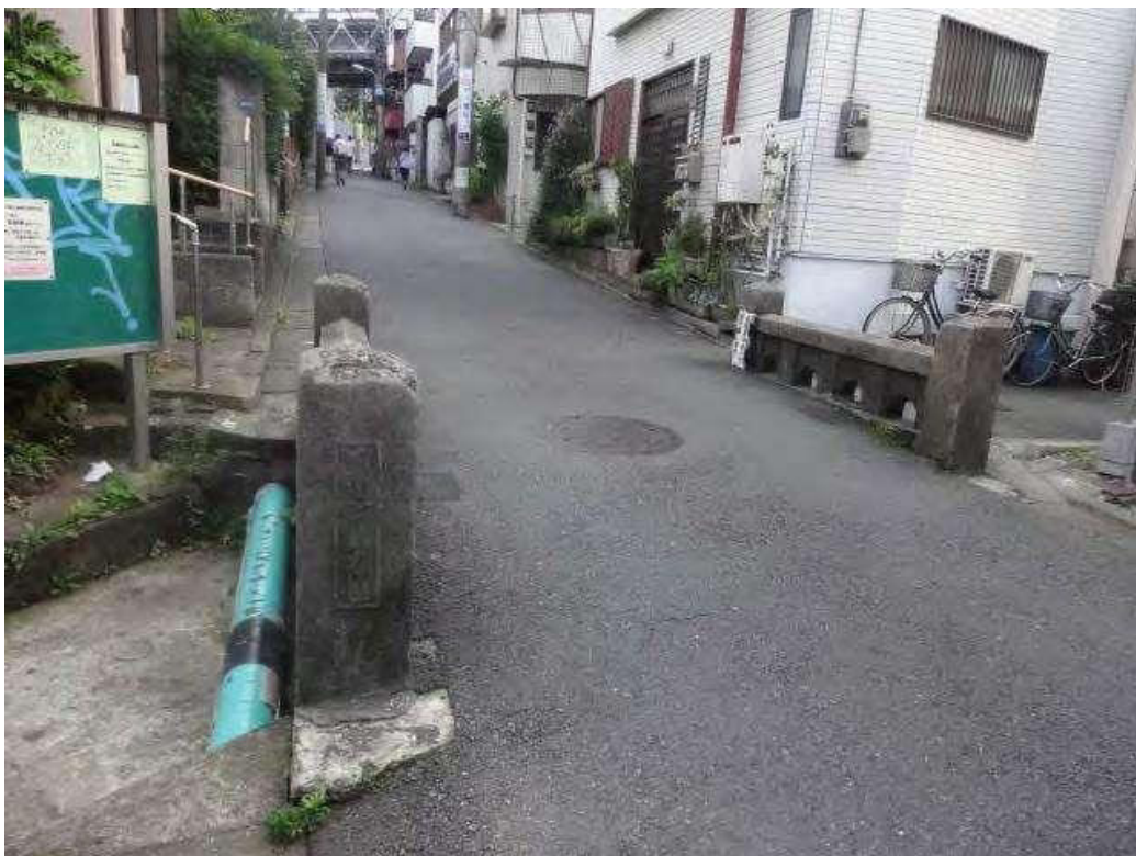
写真 3-1 古戸越橋のある位置
