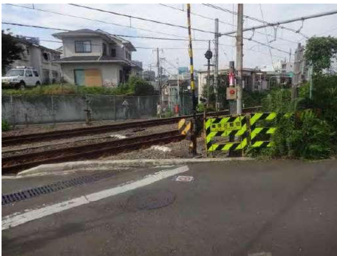
写真 5-3 踏切とマンホール
