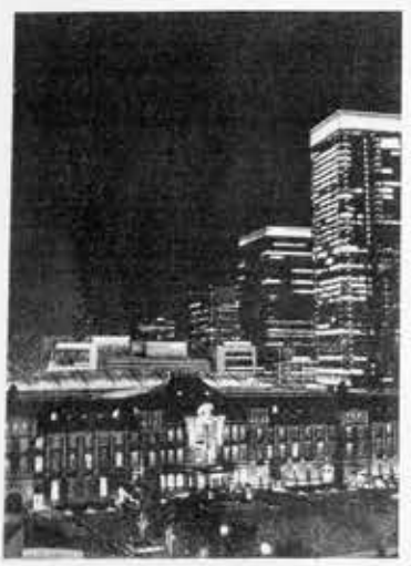
駅周辺の夜間照明
