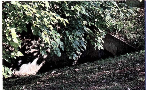
小金井分水にある山王の築樋(小金井市で)
