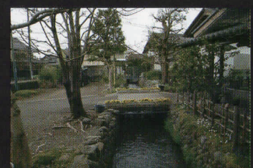
No. 54 砂川分水の開渠遺構
