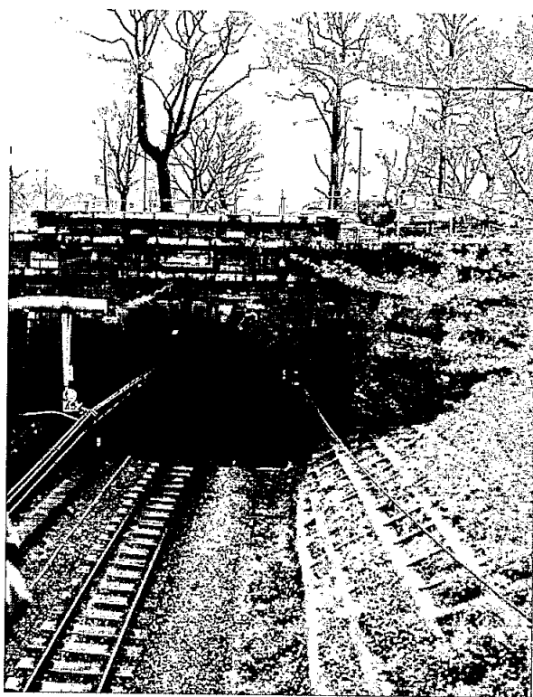
旧甲武鉄道 御所トンネル
